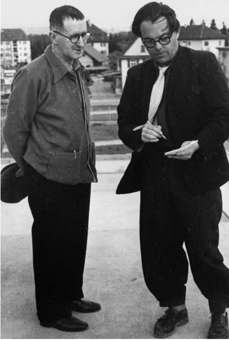
Baustellenbesichtigung mit Max Frisch.
